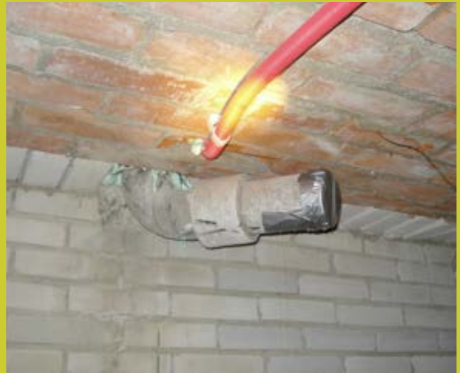
Asbestbevattend leidingwerk
