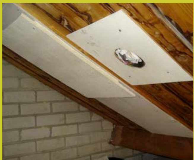
Asbestbevattend dakbeschoot
